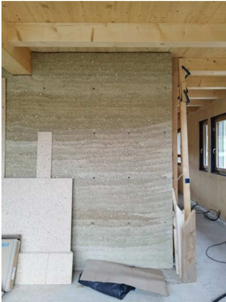
Projekt «Earth Batteries»: Stampflehm als thermischer Massespeicher in einem Vollholzhäus, ausgeführt durch Kollektiv Erdikal.
