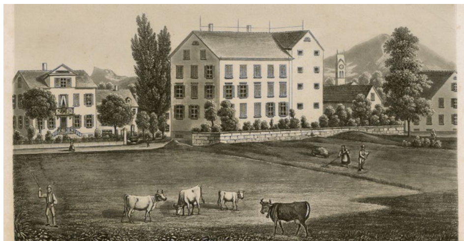
Wo einst das Bezirksgebäude stand, befindet sich heute das Gemeindehaus. (Aquatinta, Künstler unbekannt, publiziert 1870)
